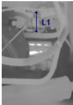
Obr. 3 a Termovízny snímok výstupného vedenia hydrogenerátora pred meraním
